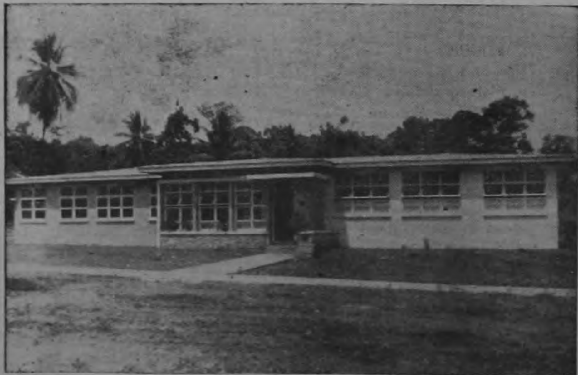
Esta es la Unidad Sanitaria de Siquirres, construida por la actual Administración con un costo de ₡ 178.450.— La construyó el Ministerio de Obras Públicas y llena todos los requisitos modernos de arquitectura e ingeniería, lo mismo que ofrece las mayores facilidades para el uso múltiple a que se le destina. Es una obra que garantiza el cuidado de la salud popular.—
